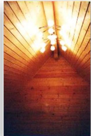
Обвязка 200x150, лаги 50x150, черный пол 25x150 пропитанная антипиреном, стропильная система профилированный брус напильный по проекту 115 x 135.
