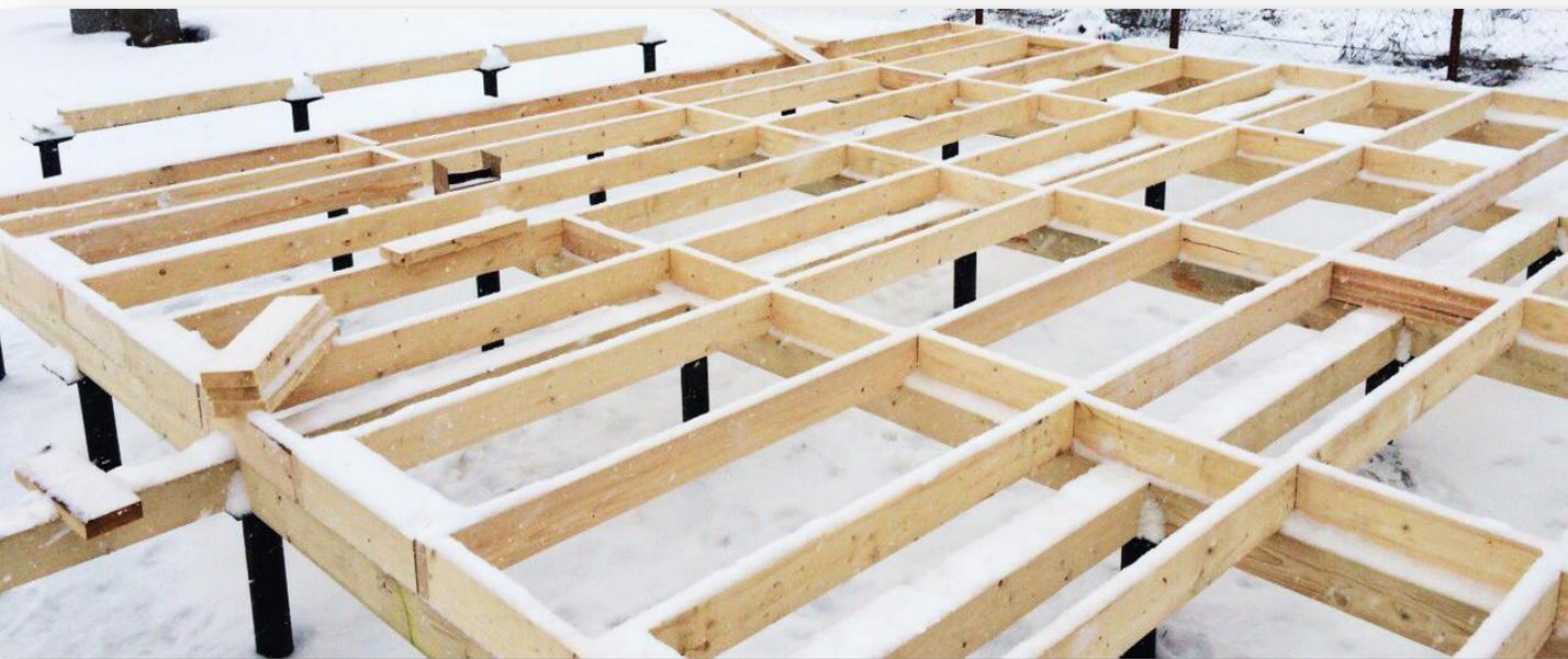
На следующих фото идет **сборка первого этажа дома**. Опытная бригада может провести эту операцию за 1 день, в зависимости от размера и сложности конструкции. Данный проект имеет размер 12,5 x 7 метров общей площадью 140 метров квадратных.
