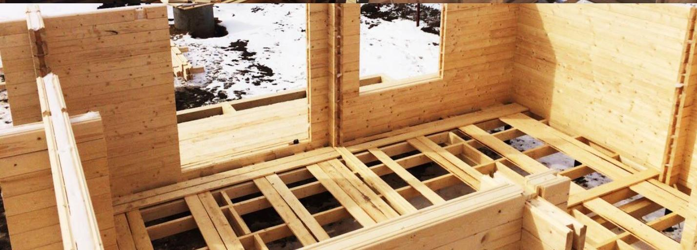
Далее виден процесс сборки с разных ракурсов. Идет **возведение второго этажа вместе с фронтонами дома**. Все проемы под окна и двери закладываются в чертежи и получаются автоматически при сборке конструктора:
